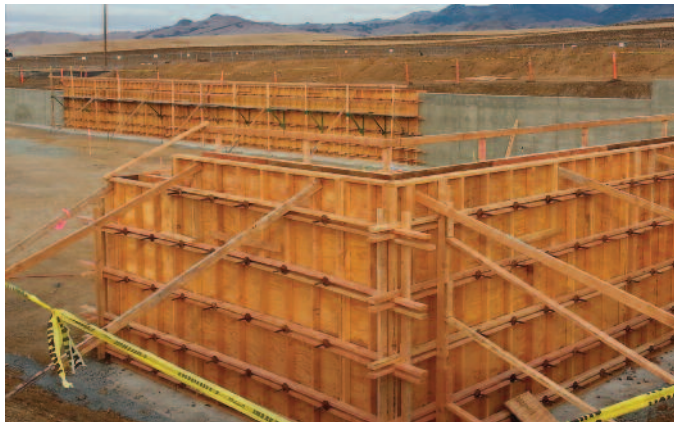
La construcción está en marcha en la actualización de la Planta de Tratamiento de Agua de Lessalt.
