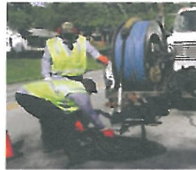
Mantenimiento de alcantarillado
