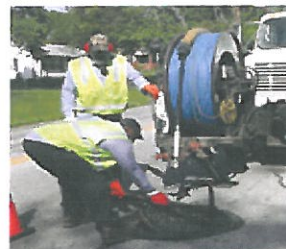
Mantenimiento de alcantarillado
